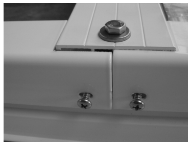
Verschraubung Glasaufnahme
