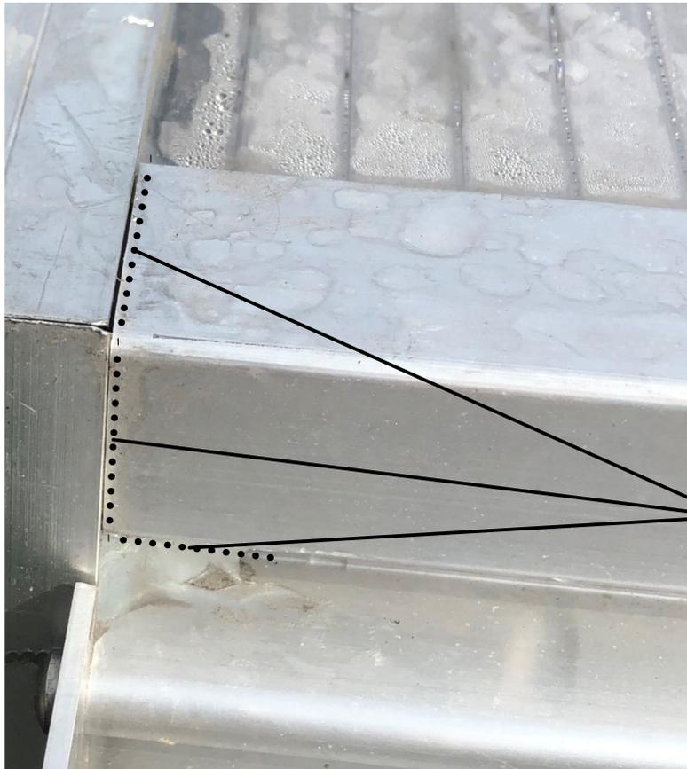
Übergänge zwischen den Profilen mit beiliegendem Silikon versiegeln.
