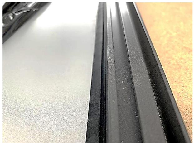
6. Die Dichtung auf der gesamten Länge des Profils gleichmäßig eindrücken (Abb. zeigt die Dichtung nicht final eingekeilt)
